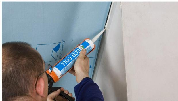
**10a. Anschluss an verputzten Schornstein (gedämmt oder 2-schalig)**
