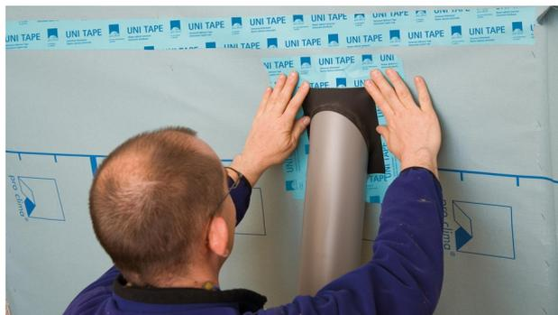
**11. Anschluss an Kabel und Rohre**
