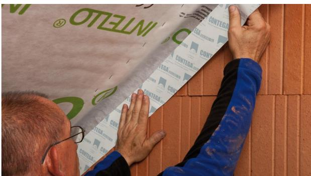
**A – Anschluss Bahn an Mauerwerkswand**
