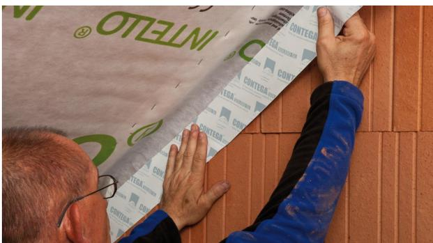
**A – Anschluss Bahn an Mauerwerkswand**
