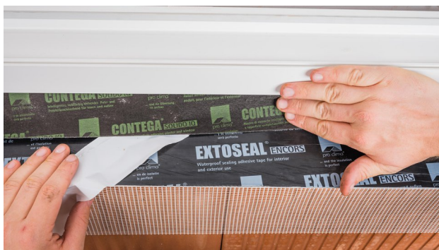
7. In der Leibung verkleben und anreiben Trennfolienstreifen abziehen und Band umlaufend verkleben.
