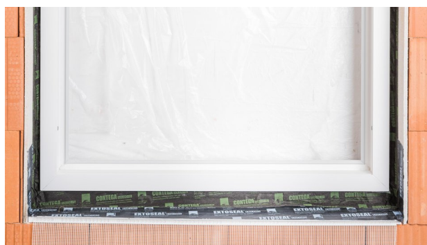
10. Fertig Fertiger luftdichter bzw. schlagregensicherer Anschluss. Band kann jetzt überputzt werden.
