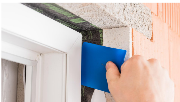
9. Fest anreiben Band umlaufend mit der Anpresshilfe pro clima PRESSFIX fest anreiben.
