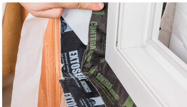
8. Ecken verkleben An den Ecken des Fensters Eckfalten luftdicht (Innenseite) bzw. schlagregensicher und wasserführend (Aussenseite) mit der Leibung verkleben.
