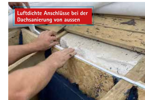
Verschliessen von Rissen bis 20 mm
