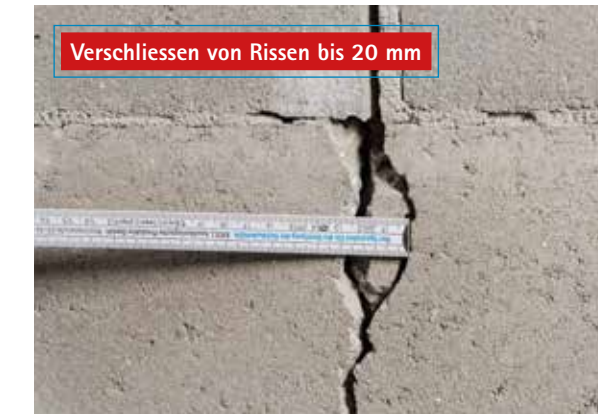
Verschliessen von Fugen und Rissen bis 3 mm
