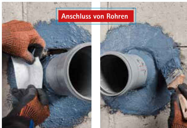
Verschließen von Löchern bis max. 70 mm Durchmesser
