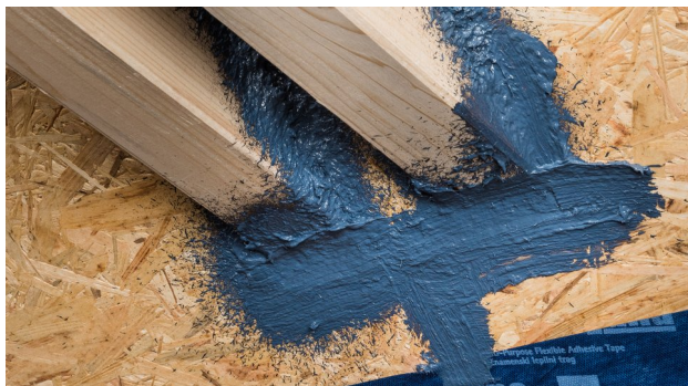
9. Raccord fini : entrait retroussé
