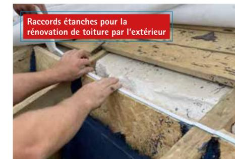
Raccords étanches pour la rénovation de toiture par l'extérieur
