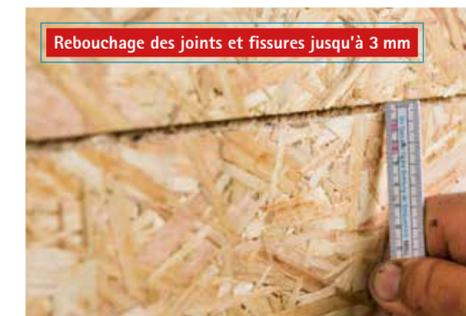
Rebouchage des joints et fissures jusqu'à 3 mm
