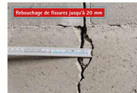
Rebouchage de fissures jusqu'à 20 mm
