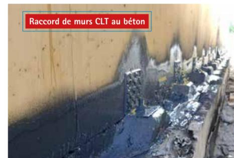
Raccord de murs CLT au béton
