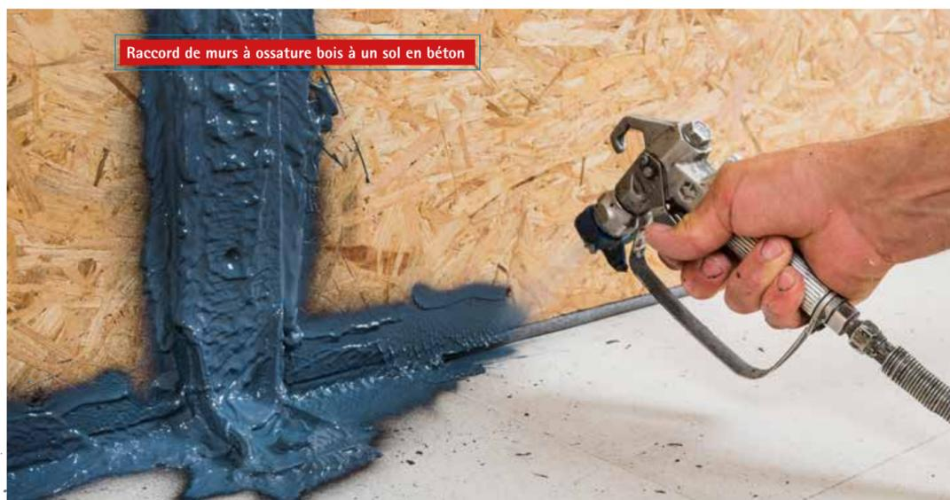
Raccord de murs à ossature bois à un sol en béton
