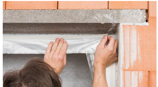
4. Fensterrahmen abkleben Dabei einen mind. 6 mm breiten Streifen auf dem Blendrahmen für den Anschluss mit AEROSANA VISCONN / FIBRE freilassen. Alternativ Fugendämmung soweit entfernen, dass eine saubere Oberfläche für den seitlichen Anschluss am Blendrahmen entsteht.
