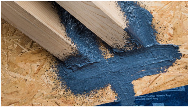
9. Fertig angeschlossene Zangendurchdringung Fensteranschluss mit AEROFIXX
