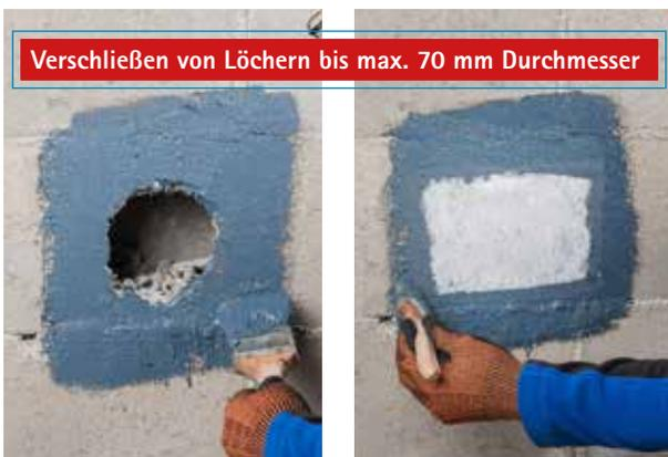
Verschließen von Löchern bis max. 70 mm Durchmesser
