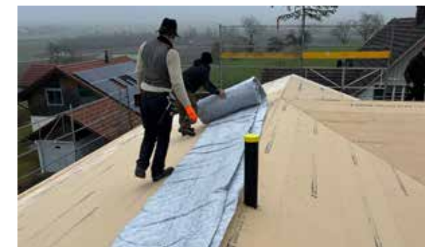
Ausrollen der vorkonfektionierten Plane
