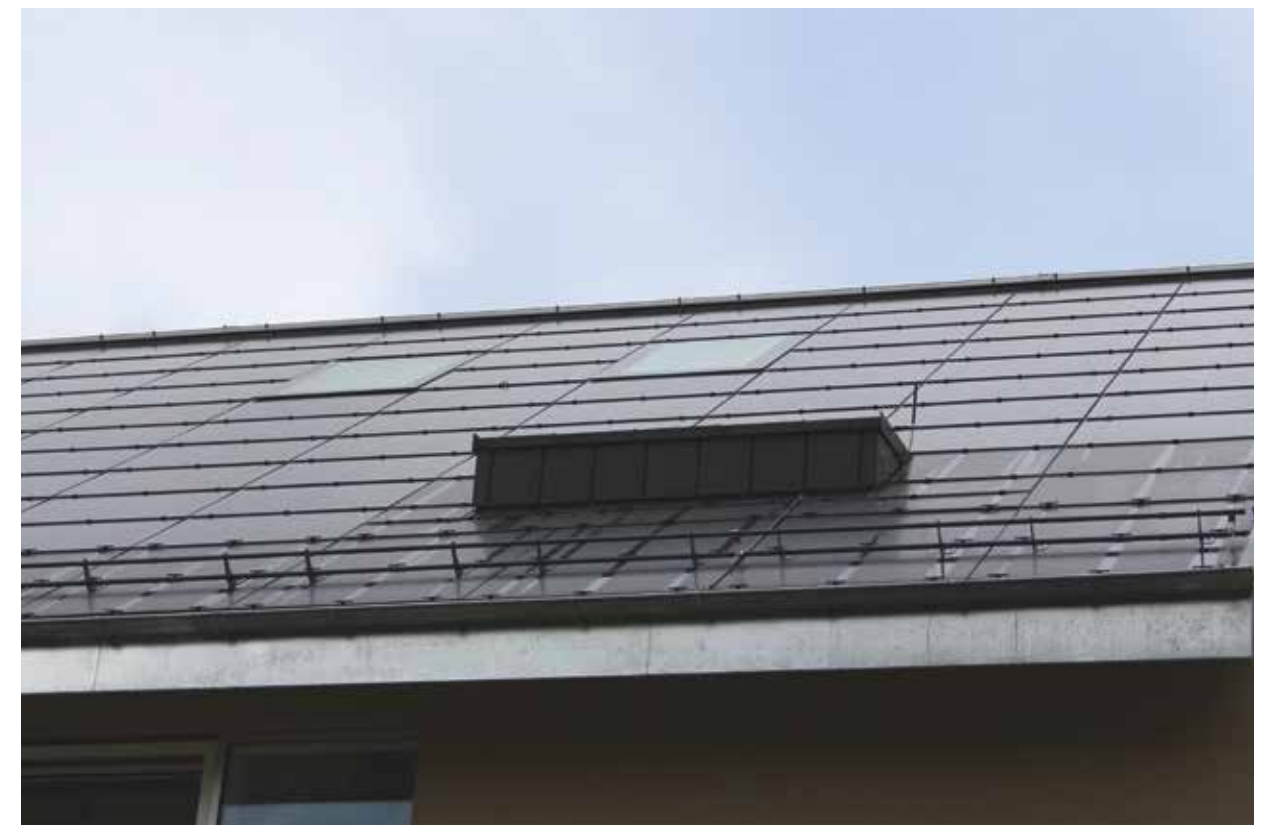
Integrierte PV-Anlage mit Unterdach SOLITEX MENTO 3000 connect
