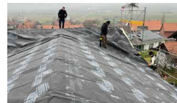
Ausgelegte Unterdachbahn SOLITEX MENTO 5000 connect
