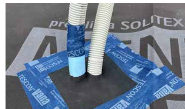
pro clima Manschetten und TESCON VANA Allround Kleband wurden eingesetzt, um Durchdringungen für Kabelrohre (mit ROFLEX 20 multi) ...
