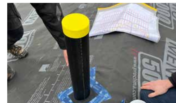
... und Dunstrohre (mit ROFLEX 100) abzudichten
