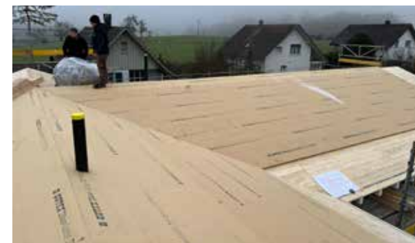
Anlieferung der vorkonfektionierten Plane zum Verlegen auf Holzfaserunterdachplatten
