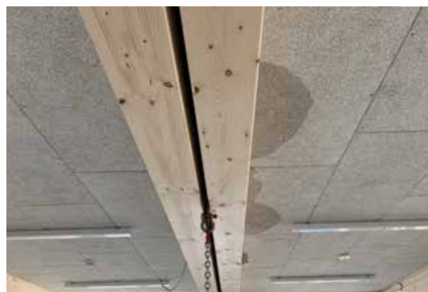
Undichter Modulstoß
