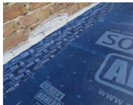
Für Anschlüsse an angrenzende Bauteile, wie aufgehende Wände aus Mauerwerk, Beton, Holz und Holzwerkstoffplatten.
