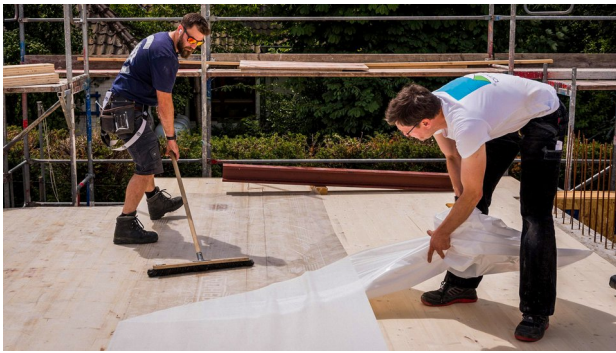
4.3 Bahnen verlegen, bei Nutzung geteilter Trennlage Die nächste Bahn mit 10 cm Überlappung auf die bestehende Bahn kleben. Die Bahnenüberlappung mit PRESSFIX XL anreiben.
