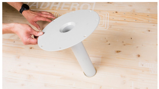
9. Entwässerung: Einbau ADHERO Floor Drain ADHERO Floor Drain in das Bohrloch einschieben und ggf. mit Senkschrauben sichern.
