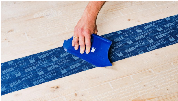
6. Die alternative Verklebung der Bahnen untereinander Alternativ Bahnen untereinander mit TESCO VANA verkleben. Band mittig ansetzen und Zug um Zug faltenfrei verkleben. Band fest anreiben.
