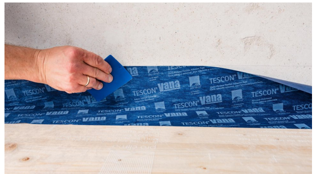
7. Anschluss an Betonwand Anschlüsse mit dem Systemklebeband ausführen und diese mindestens 50 mm auf die Bahn führen. Anschlüsse an aufsteigende Bauteile ca. 10 cm (Oberkante der nachfolgenden Bauteilschichtung) hoch führen. Anschlussflächen prüfen und ggf. mit TESCO PRIMER RP oder TESCO SPRIMER vorbehandeln. Beim Anschluss mit einem Produkt der sprühbaren AEROSANA VISCONN-Familie die Bahn ebenfalls primern.
