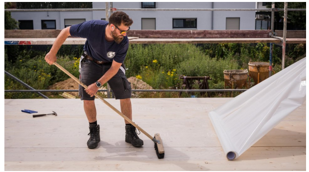
5. Alternativ: Bahn in Einem auf Fläche verkleben Nur für geübte Verarbeiter: Die Bahn an der Markierung entlang ausrollen und Zug um Zug mit dem Untergrund verkleben.
