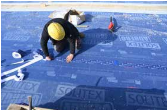
Zur Verklebung der Bahnen untereinander.
