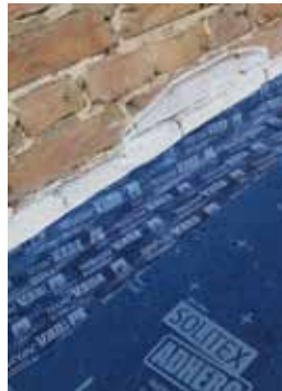
Für Anschlüsse an angrenzende Bauteile, wie aufgehende Wände aus Mauerwerk, Beton, Holz und Holzwerkstoffplatten.
