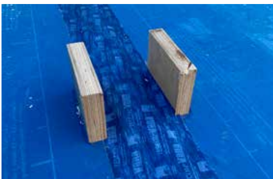
Zur Abdichtung von komplizierten Durchdringungen ...
