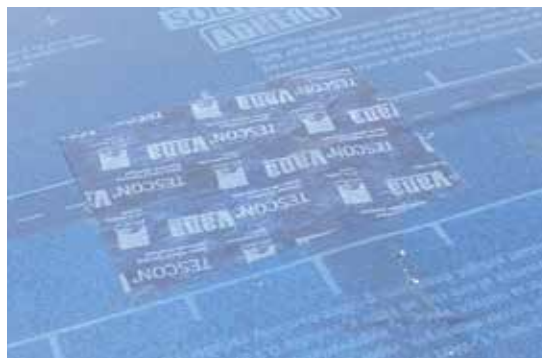
Zum Abdichten von beschädigten Stellen in der Bahn.
