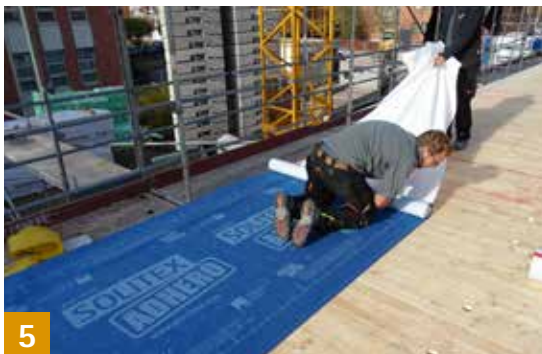
PRESSFIX XL Ermöglicht das einfache und schnelle Anpressen von SOLITEX ADHERO 1000/3000
