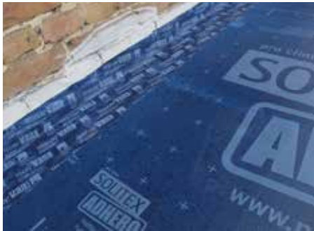
Für Anschlüsse an angrenzende Bauteile, wie aufgehende Wände aus Mauerwerk, Beton, Holz und Holzwerkstoffplatten.
