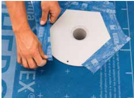
Zum Anschluss von Gullys zur Flächenentwässerung an SOLITEX ADHERO.
