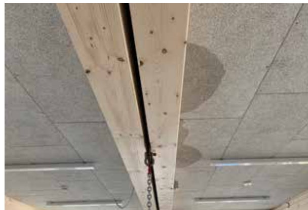
Undichter Modulstoss
