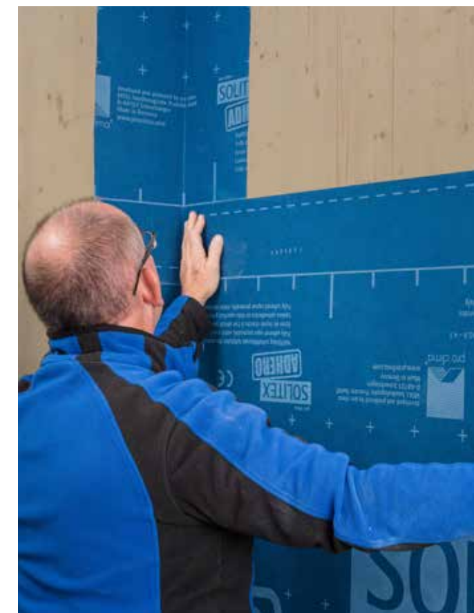
Luftdichtung und Witterungsschutz Wand
