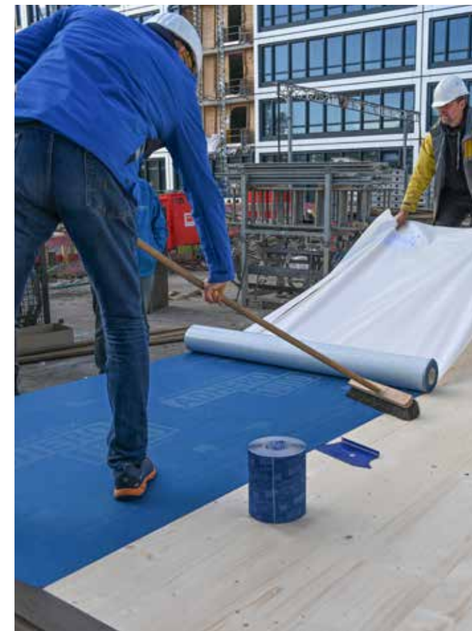
Tijdelijke bescherming vloer
