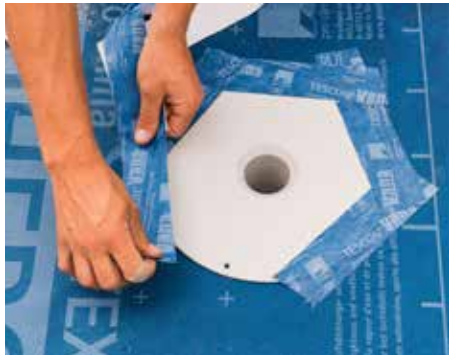
Voor het aansluiten van waterafvoeren op SOLITEX ADHERO
