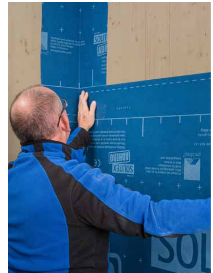
Luchtdichting en bescherming tegen weersinvloeden wand
